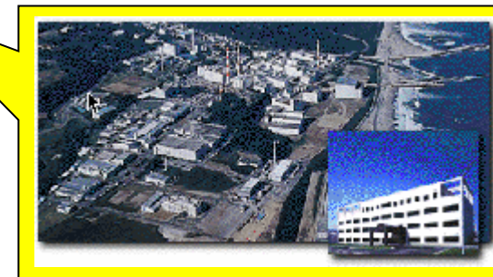
東海研究開発センター 地層処分基盤研究施設(ENTRY) 地層処分放射化学研究施設(QUALITY)
